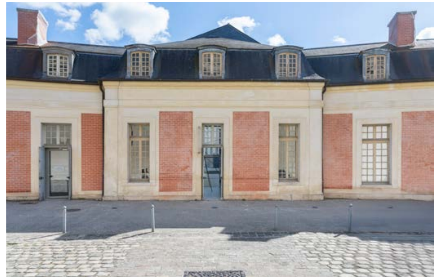
Vue du centre d'art depuis la cour de la maréchalerie ÉNSA Versailles, 2025. Crédit photographique : Nicolas Brasseur.
