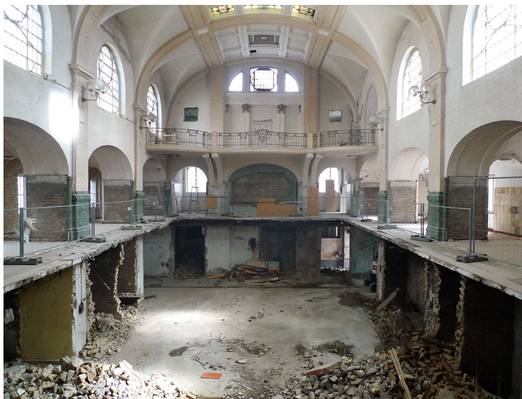
Démolition d'une partie de l'établissement municipal de bains (piscine) de Colmar dans le cadre du projet d'extension du Musée Unterlinden ©Herzog & de Meuron
