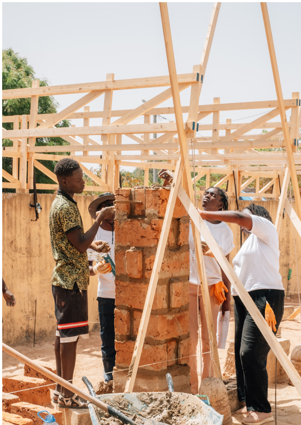
Co-construction d'un bâtiment-abri au Sénégal
