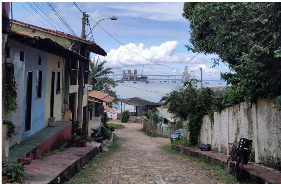
Structures d'accostage des terminaux à usage privé de « Murucupi » et de « Ponta da Montanha », vues depuis le quartier de Vila do Conde, au sud de la municipalité de Barcarena. Photographie d'Alexandre Gaiser Fernandes.
