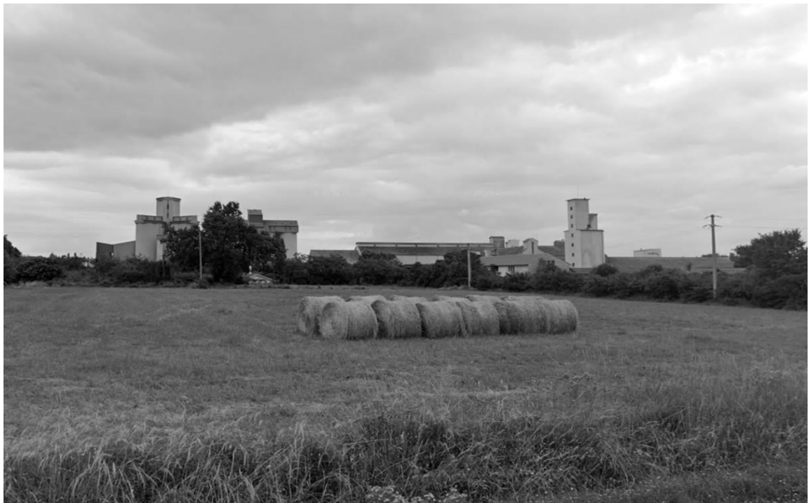
Vue d'ensemble du site de silos de Lombez (Gers).
