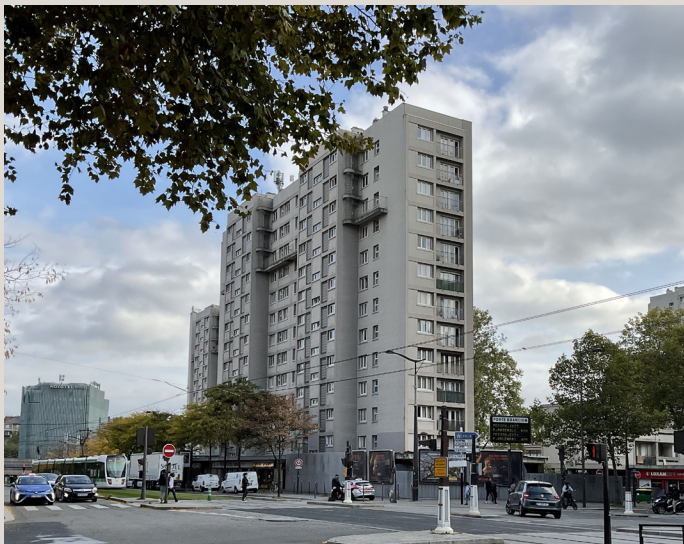
Porte Brancion Ensemble Paris Habitat
