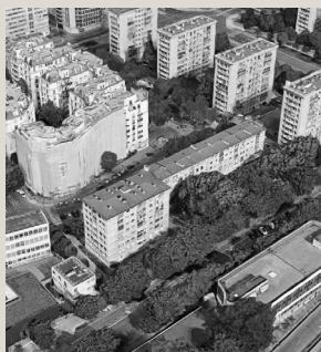
Logements Porte de Vincennes (1959)
