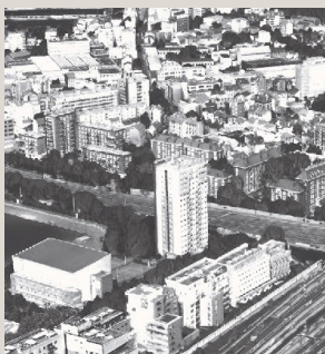
Tour Poissonniers, bâtiment de Raymond Lopez (1958)
