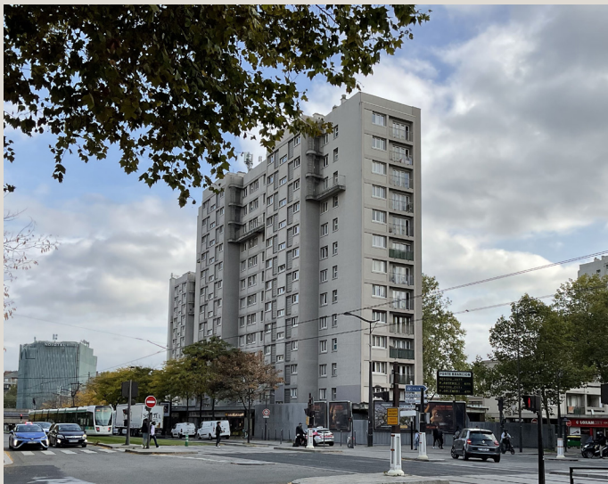
Porte Brancion Ensemble Paris Habitat
