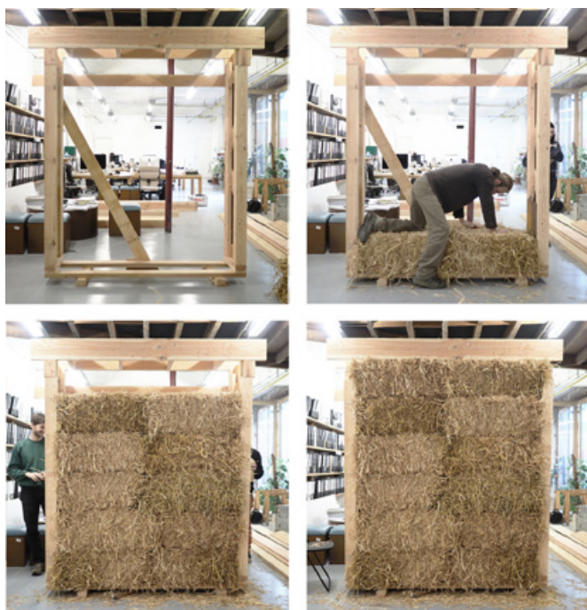
2. Prototype réalisé au cours d'une journée de workshop par les architectes et l'artisan en vue de l'optimisation du système constructif, 2020. © Karbon.
