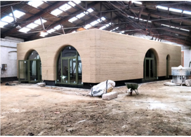
4. Projet de centre éducatif en cours de construction, 2018. © Pauline Lefebvre.
