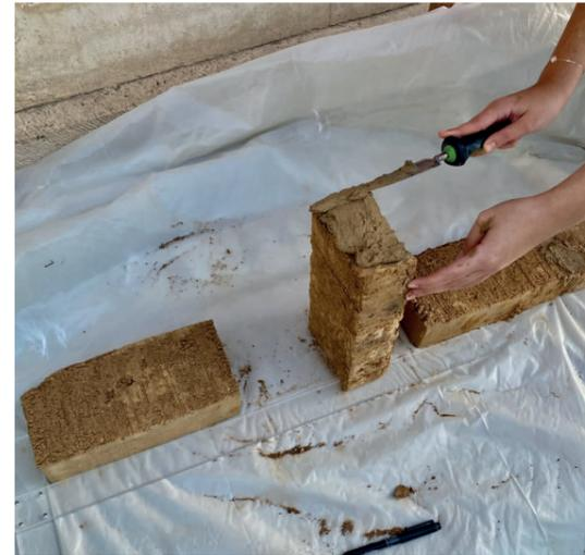
Réalisation d'un mur en brique de terre crue compressée
