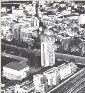
Tour Poissonniers, bâtiment de Raymond Lopez (1958)
