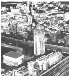
Tour Poissonniers, bâtiment de Raymond Lopez (1958)
