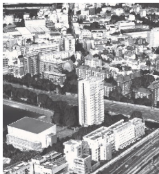
Tour Poissonniers, bâtiment de Raymond Lopez (1958)
